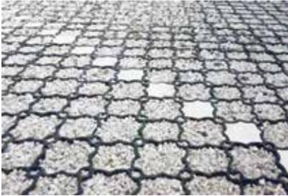
Ячейки решеток можно заполнить мульчей или мелкими камнями и они не будут втаптываться в землю или разноситься при ходьбе. С использованием разметки можно маркировать парковочные места.
