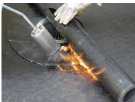
4. Наклеить 2-й слой гидроизоляции (до обжимного фланца)
