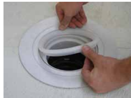
9. Убедиться в правильности установки прозрачного пластикового кольца
