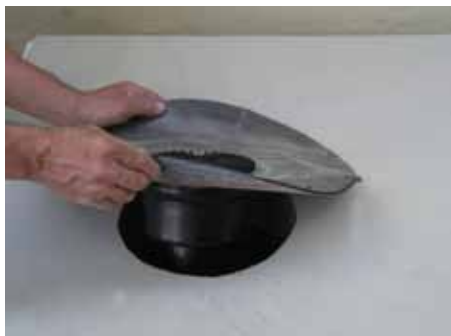
1. Прodelать отверстие Ø 255мм, закрепить воронку HL62H
