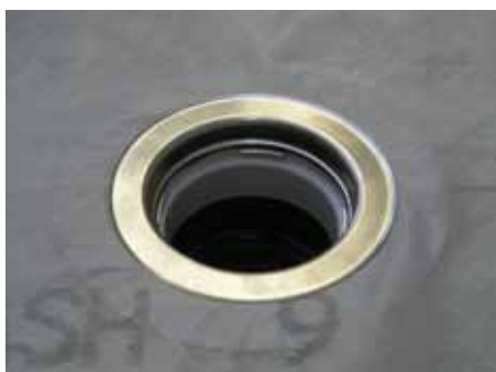
10. Зажать фильтрующий слой фиксирующим фланцем элемента HL350.0
