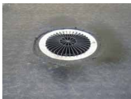
5. Так должна выглядеть воронка после укладки гидроизоляции
