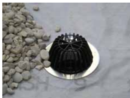
11. Установить листоуловитель, выполнить засыпку гравием (фракция: 20+40 мм)
