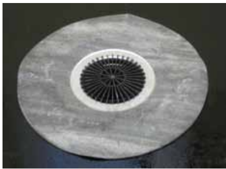
2. Нанести праймер, наклеить 1-й слой гидроизоляции
