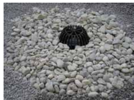
12. Засыпать гравием остальную поверхность кровли
