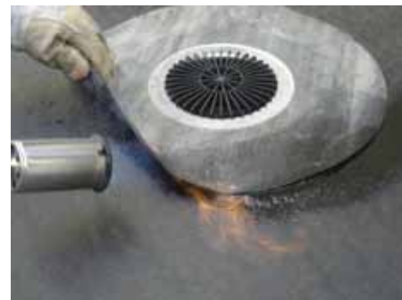
3. Приварить полимербитумное полотно воронки
