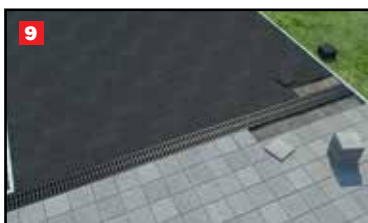
Соедините каналы в единую линию и установите на бетонное основание.
