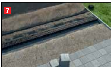
Соедините каналы в единую линию и установите на бетонное основание.
