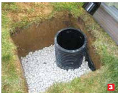
Вставьте нижнюю часть трапа и засыпьте речным камнем или мытым щебнем.
